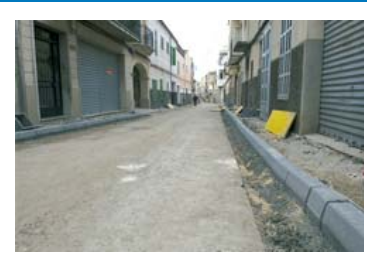
Paviment de carrers de Manacor
