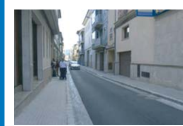
Paviment de carrers de Manacor
