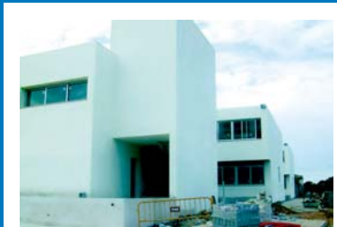
Obres IES Porto Cristo
